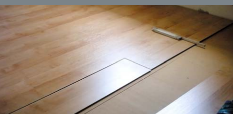
Betondecke mit AGEPAN® TEP N+F und Laminatboden.
